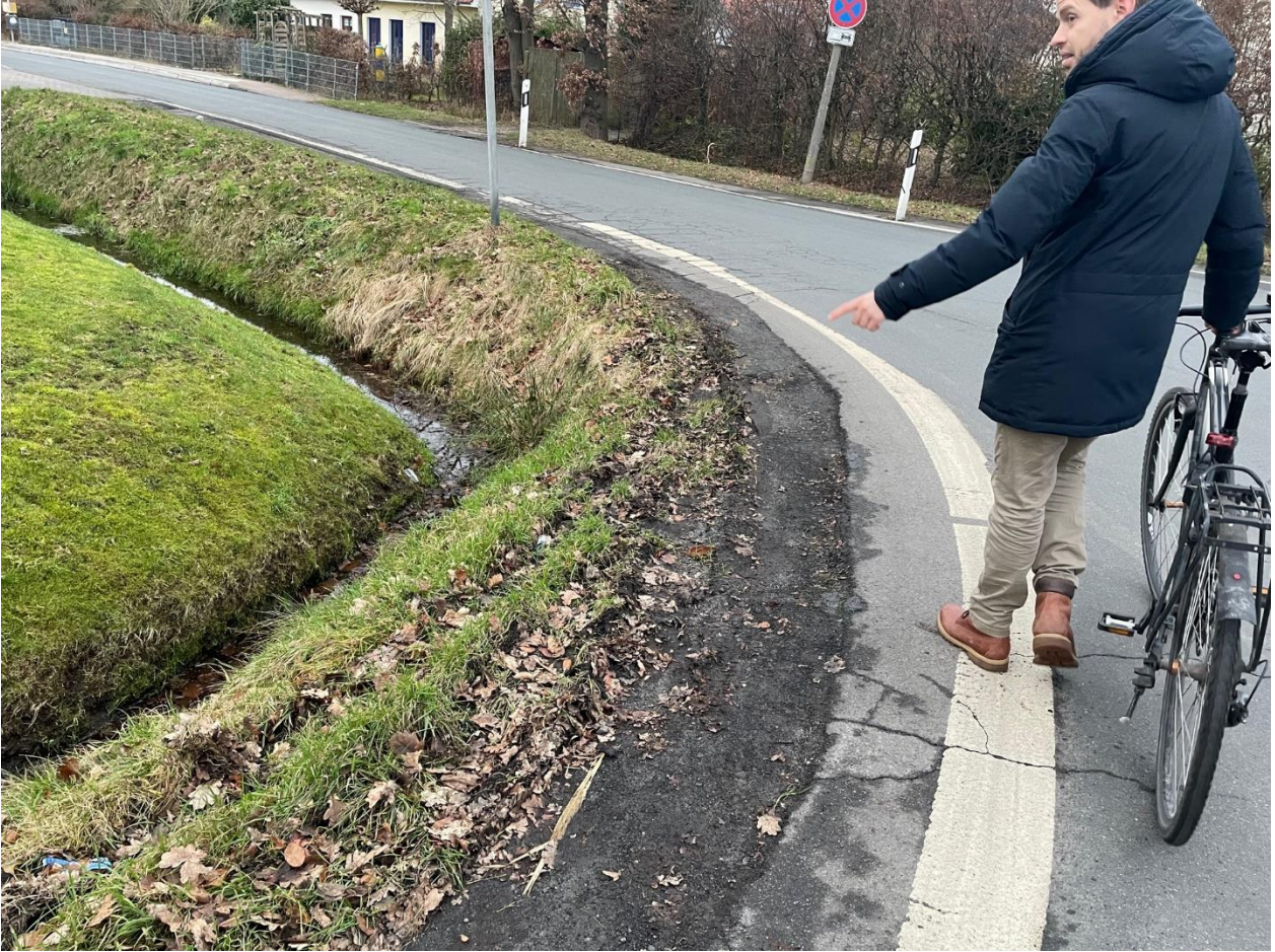
Fahrspuren belegen das Schneiden des Gehweges
