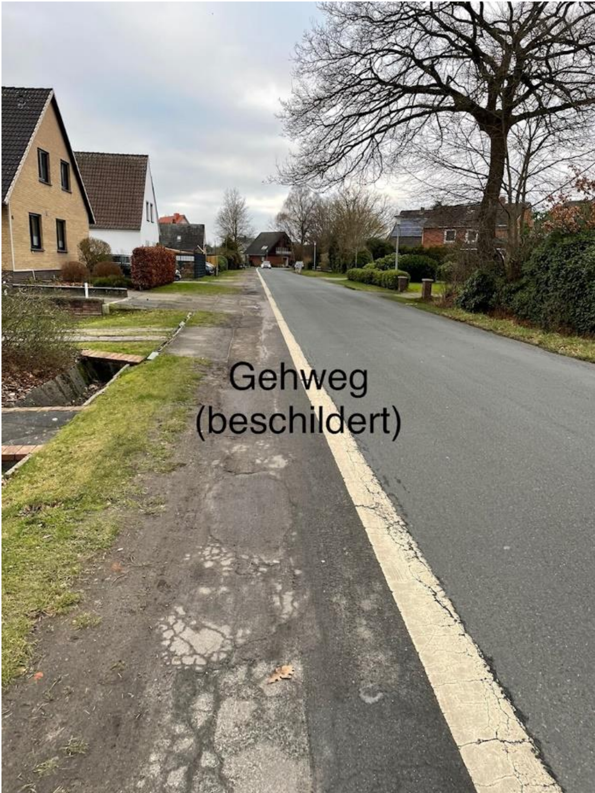
Beispielfoto zum Zustand des Gehweges
