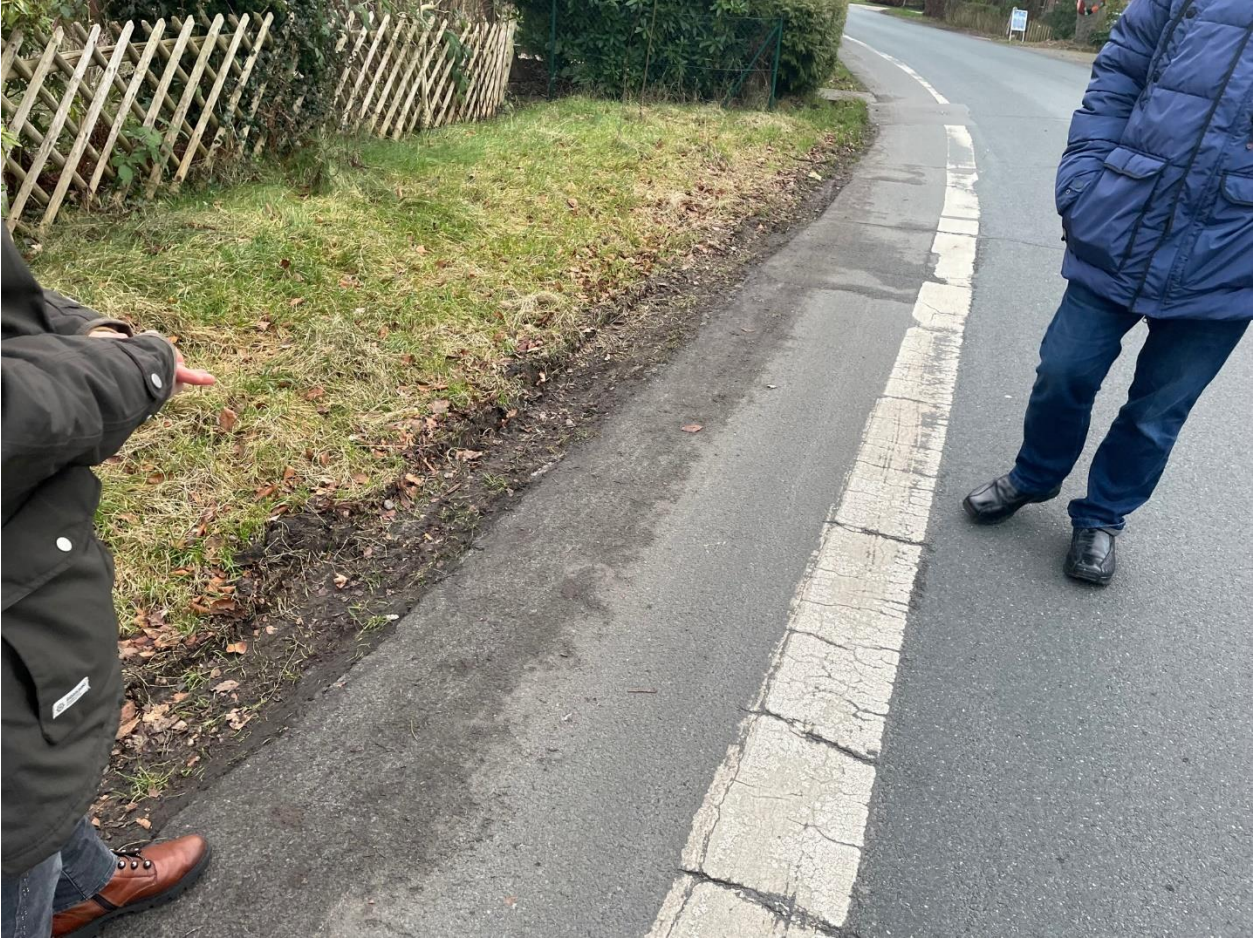
Fahrspuren belegen das Schneiden des Gehweges
